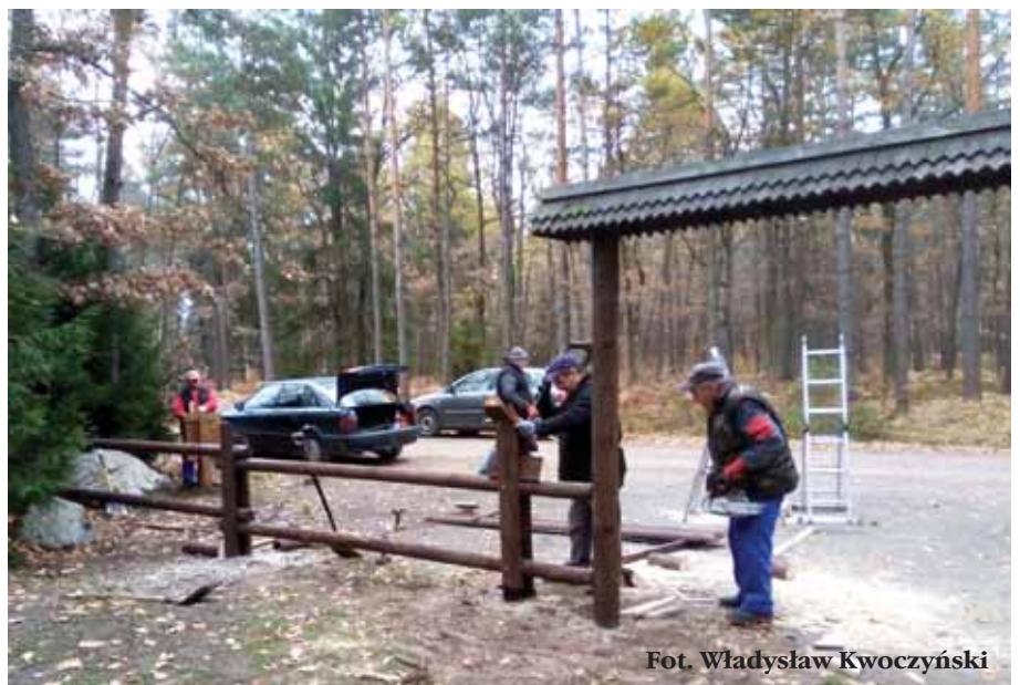
Prace przy ogrodzeniu przebiegały sprawnie.
