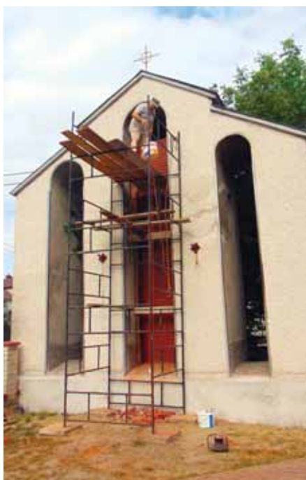
Murowanie wnętrza z cegły klinkierowej.
