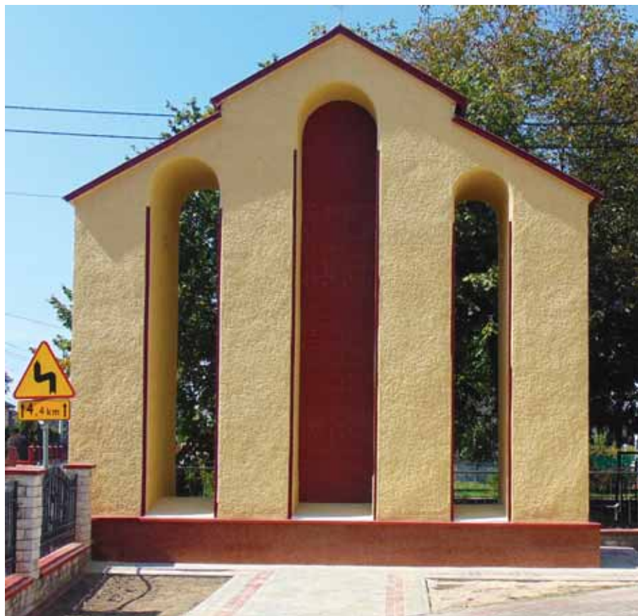
Dzwonnica po remoncie.
