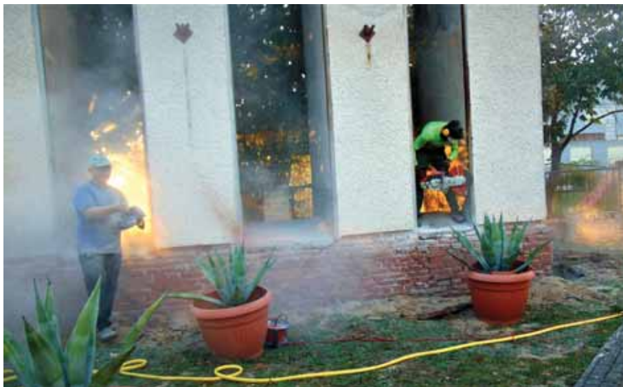
Tynkowanie cokołu dzwonnicy.
