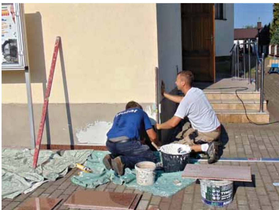
Płytkarze wykonywali swoją pracę dokładnie i sumiennie.
