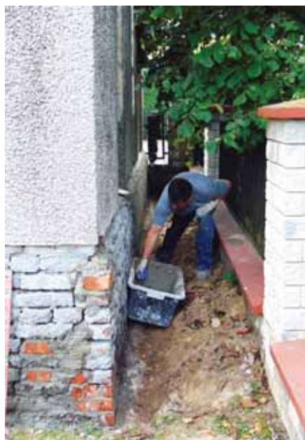
Przy usuwaniu resztek lastryka z dzwonnicy pracowali strażacy.
