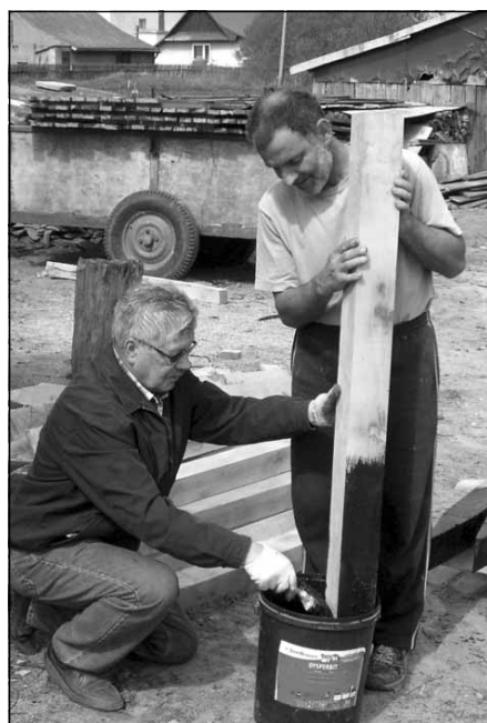
Impregnowanie słupków na ogrodzenie stacji. Od lewej: Władysław Kwoczyński i Robert Selwet.
