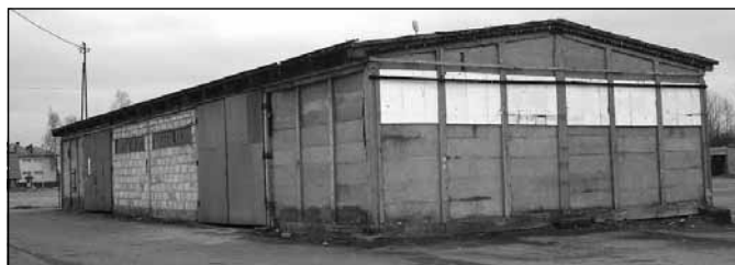
Budynek przed rozbiórką.
