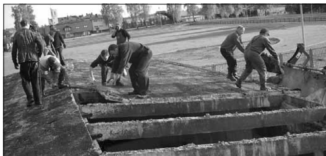
Strażacy podczas rozbiórki budynku.
