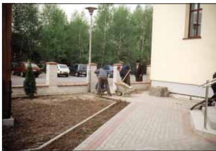
Układanie kostki brukowej na placu przykościelnym w Bratkowicach. Fot. Wł. Kwoczyński
