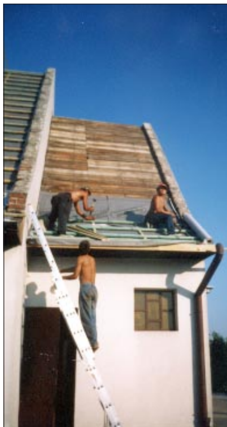
Wymiana pokrycia dachowego na kościele parafialnym w Błędowej Zgłobieńskiej. Lipiec 2006.
