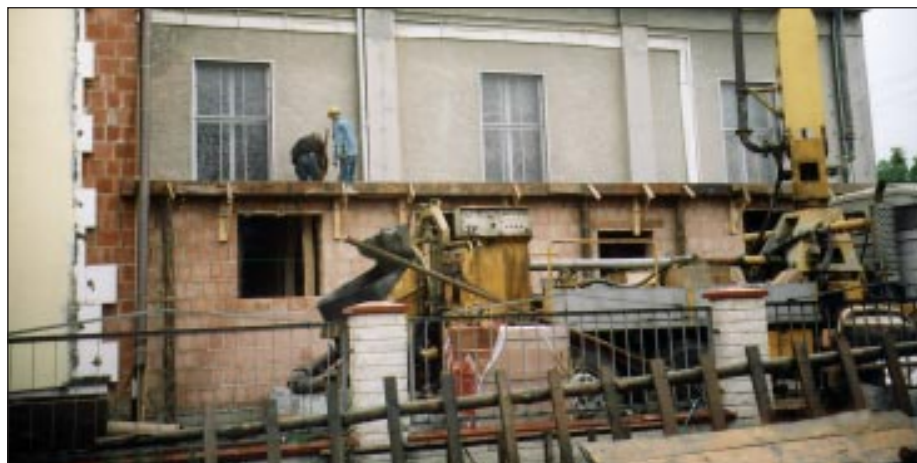
Betonowanie stropu na nowo wybudowanej zakrystii.
