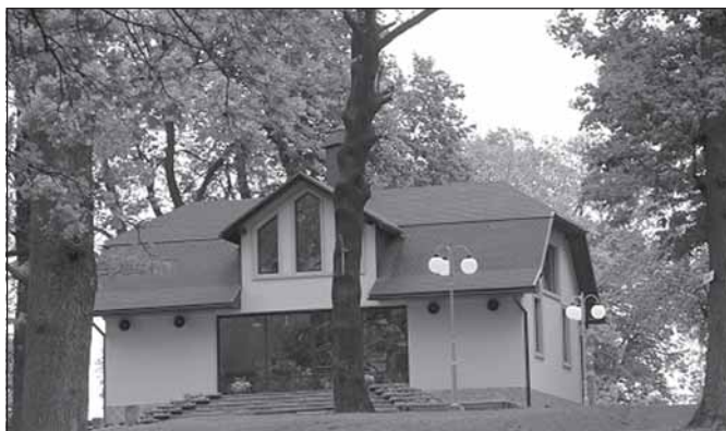
„Bobółka” – widok obecny. Fot. autor
