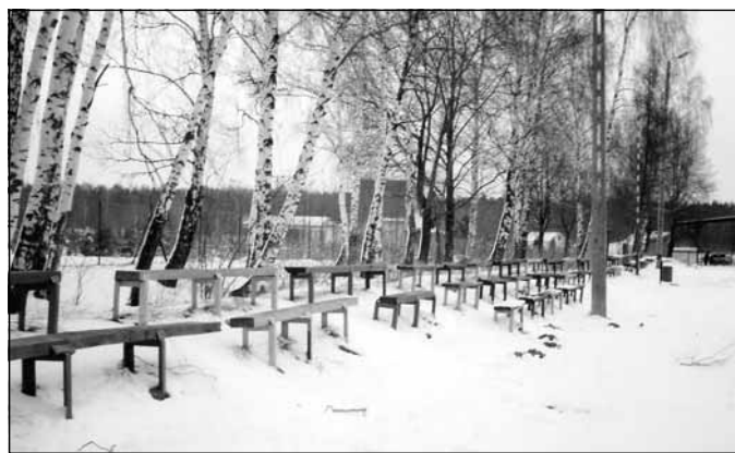
Trybuny dla kibiców na bratkowickim stadionie (przed i po przebudowie).
