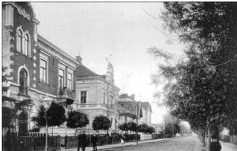
Ulica Krakowska, prowadząca w kierunku Przybyszówki i Świlczy. Tu dochodziło do licznych napadów, kradzieży i włamań. Fot. archiwum
