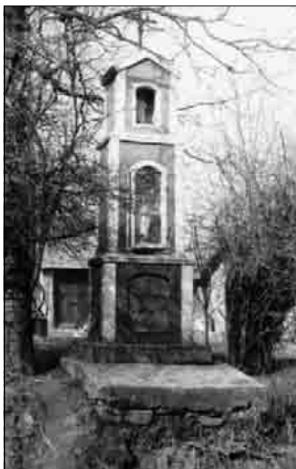
Nowa kapliczka na miejscu starej, wybudowana w 1947 r. przez Andrzeja Wajdę. Stan z lat 70. XX w. Fot. J. Zdun
