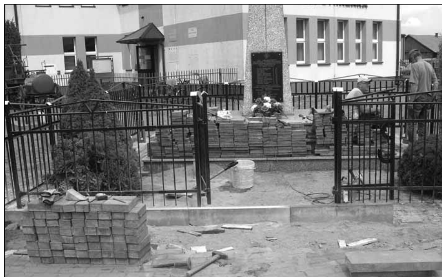
Układanie kostki brukowej.
