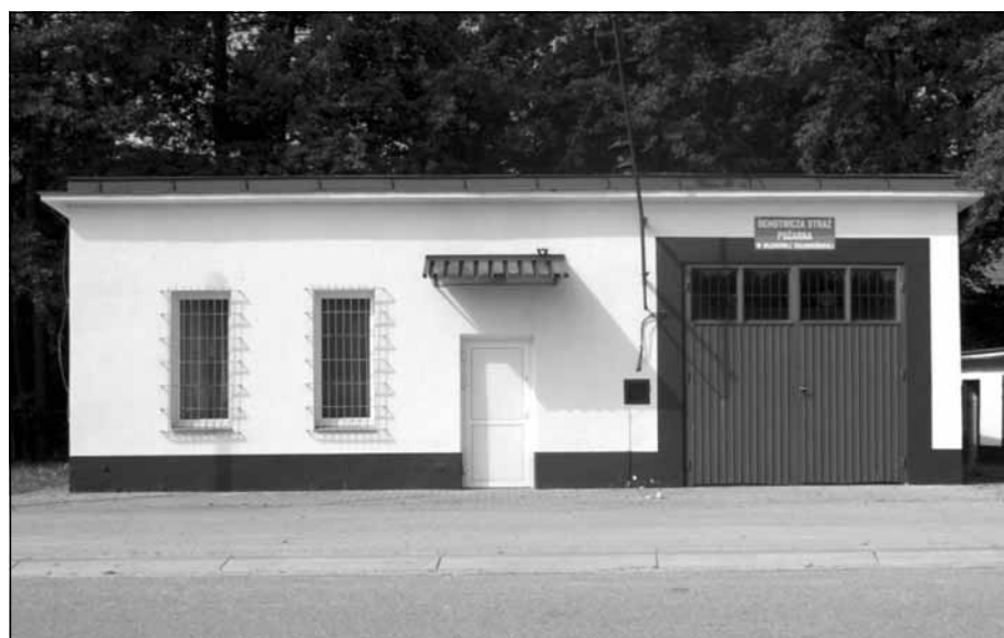
Budynek remizy Ochotniczej Straży Pożarnej.
