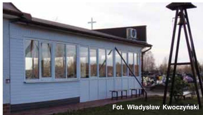
Jeden z elementów instalacji klimatyzacyjnej widoczny na dachu kaplicy.
