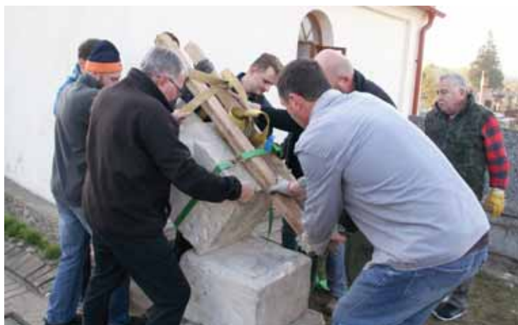
Prace przy ustawianiu elementów nagrobka ks. Juliusza Trandy w czasie jego renowacji. Fot. Archiwum TPŚ
