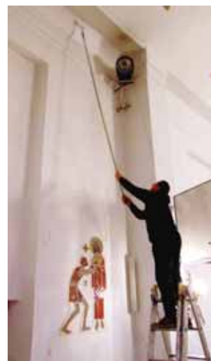
Malowanie ścian wewnątrz kościoła.
