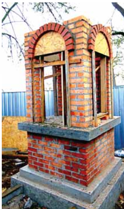
Kapliczka w trakcie prac budowlanych.
