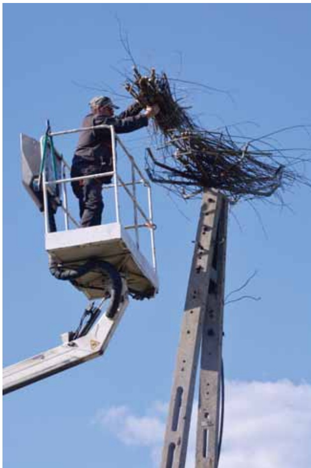
Układanie gałęzi na platformie przez p. Kazimiera Łagowskiego, stanowisko koło stacji kolejowej
