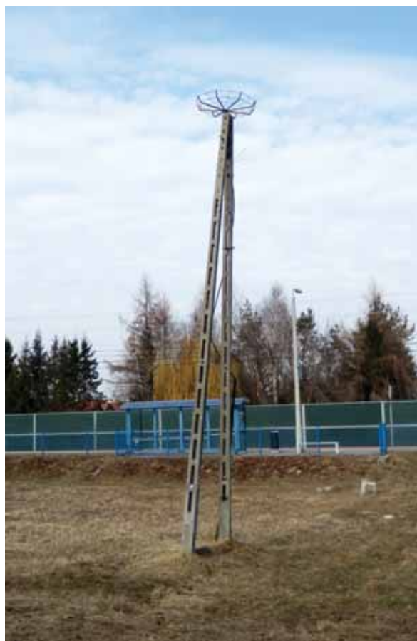
Platforma gniazdowa na słupie w rejonie stacji kolejowej w Trzcianie. Stan przed przygotowaniem do zasiedlenia przez bociany
