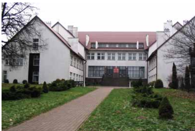
Budynki ZST-W w Trzcianie.
