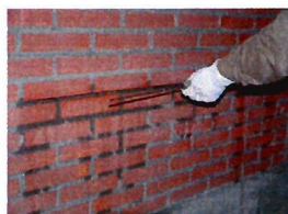
Zatopienie spirali festspiro w zaprawie festmörtel
