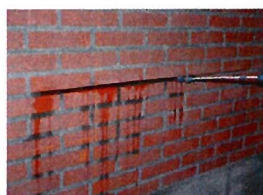
Oczyszczenie i zmoczenie bruźdy
