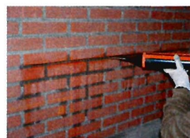
Aplikacja pierwszej warstwy zaprawy festmörtel
