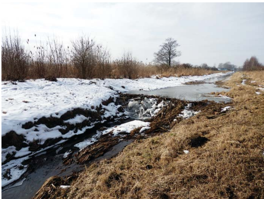
4 Tama bobrowa na potoku Mrowla w rejonie dużego stawu „Olszyny” w Trzcią, stabilizująca poziom wody w tym stawie. Uporczywie burzona. W jej miejscu należy wybudować betonowy próg spiętrzający wodę
