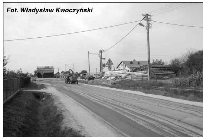
Baza materiałowa „Budimex-u” – wykonawcy odcinka autostrady w Bratkowicach.
